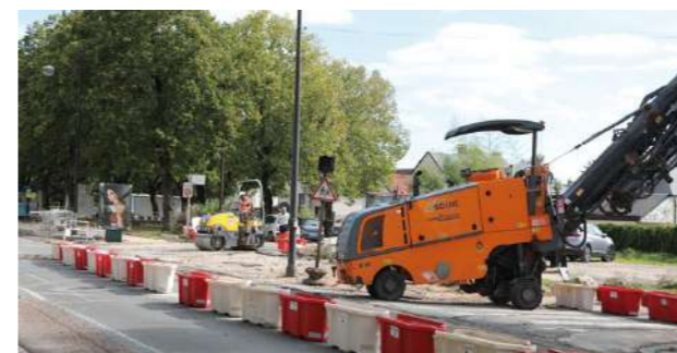
18 septembre 2023 Lancement des travaux de requalification de la rue Charles Beauhaire.
